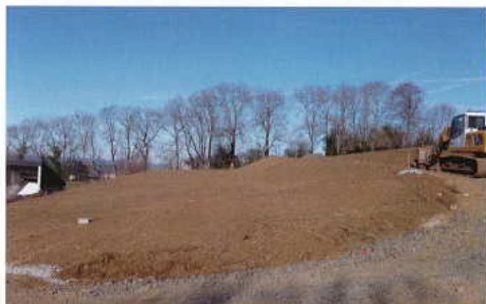
Automne 2011, terrassement du lotissement les Cotes II.
