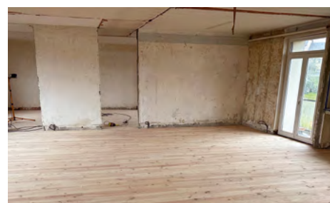
Nouvelle salle associative (travaux en cours)
